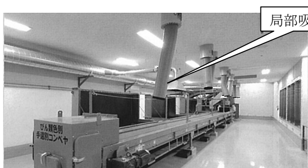
粉じん対策例 局部吸引
