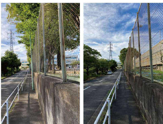
⑦西側歩道
