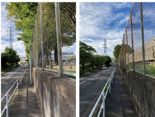
⑦西側歩道
