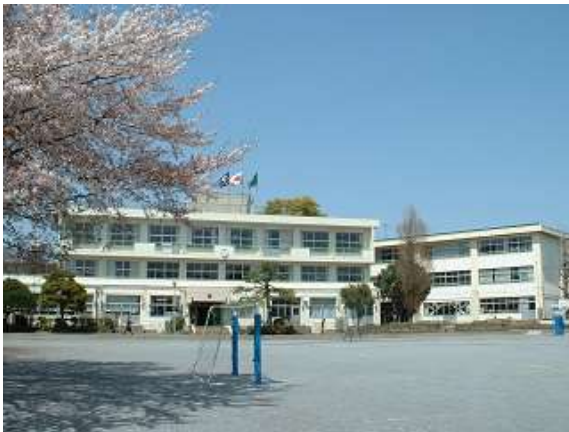
<図 1-1> 南第一小学校（築 56 年）
