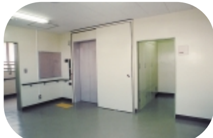
バリアフリー対応のエレベーター設置(4階)
