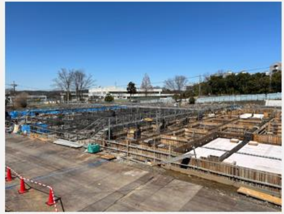
3月27日の建設地
