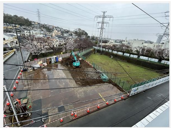
4月3日の建設地
