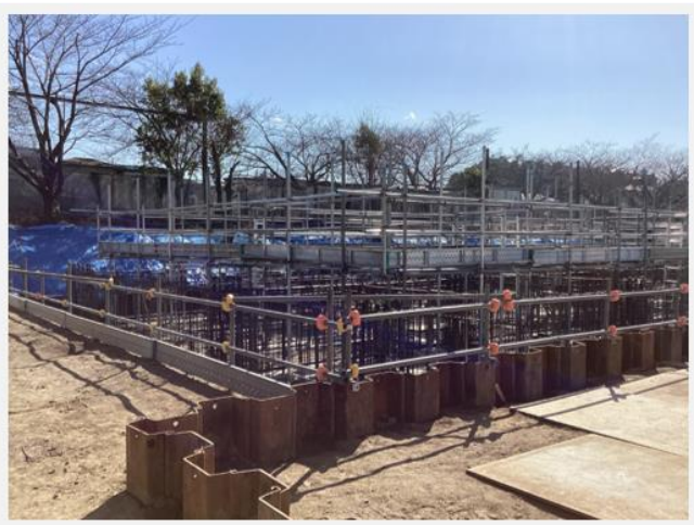
3月22日の建設地
