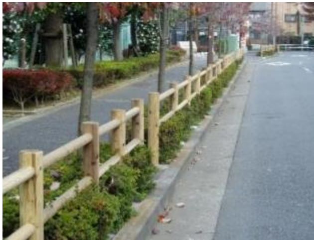
間伐材を使用した木製防護柵の例(新宿区ホームページより引用)
