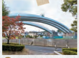
K 境川水管橋 道志川で取水した水や相模湖で溜めた水を横浜の川井浄水場や西谷浄水場へ運ぶ導水路。3本のうち1本が道志川、2本が相模湖の水。
